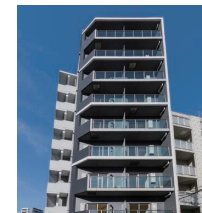
墨田区押上の賃貸施設 [住宅・店舗]
